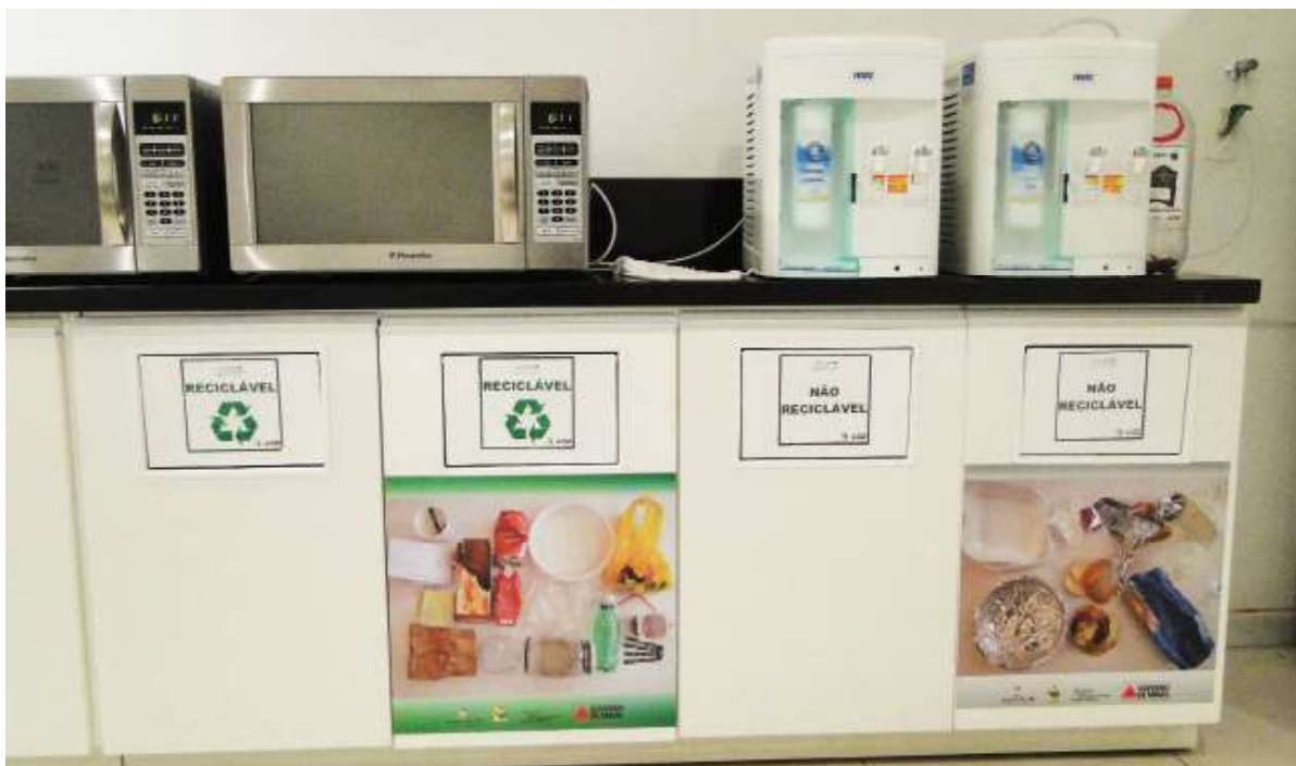
Coletores dos refeitórios adesivados
