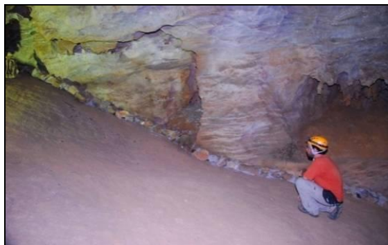
B – Linha de pequenos blocos, espeleotemas e argamassa, para ocultar cabos elétricos. Foto: V. Moura.
