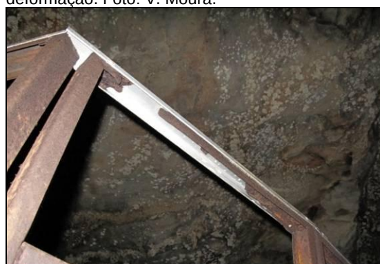
D – Vista do perfil de aço corroído (perfil de cor marrom, na foto), sob o corrimão de alumínio (perfil de cor cinza claro, na foto), apresentando pontas cortantes. Foto: V. Moura.
