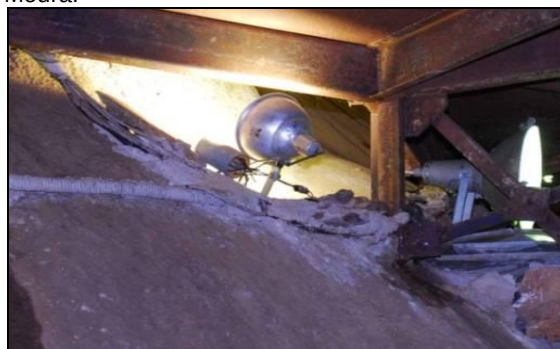
D – Eletroduto e luminárias instaladas sobre espeleotema. Neste local, os eletrodutos e luminárias poderiam ter sido fixados sob a passarela. Local: próximo ao Lago Suspenso. Foto: L. Alt.
